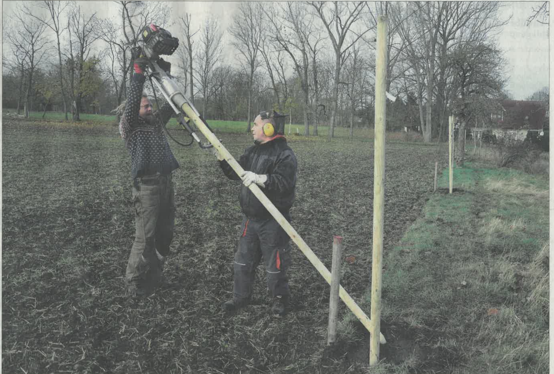
Sascha Ritter (l.) rammt zusammen mit Matthias Neumann den dritten Stabilisierungspfeiler an einem Baum am „Schmiedeweg“ in Sülldorf in die Erde.
